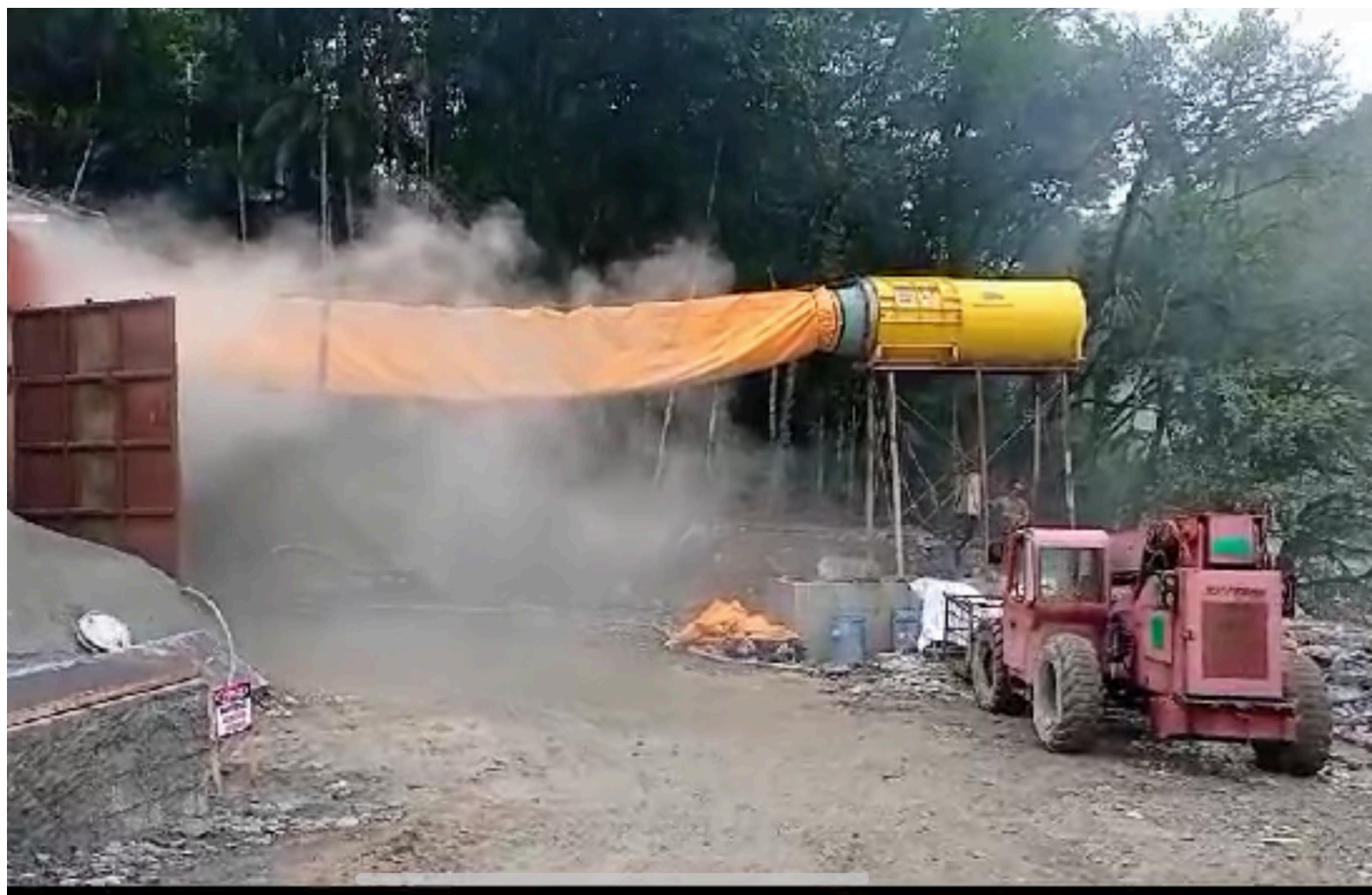
Ventilador desligado durante uma detonação
