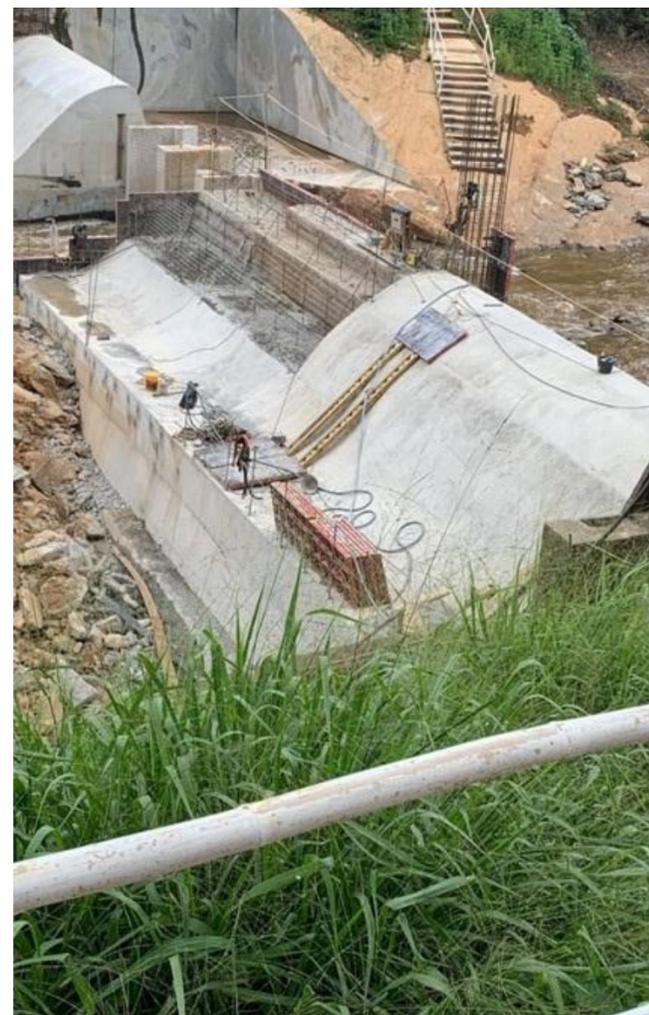
**Execução da nova estrutura do barramento, incluindo vão rebaixado para os “stop logs” provisórios**
