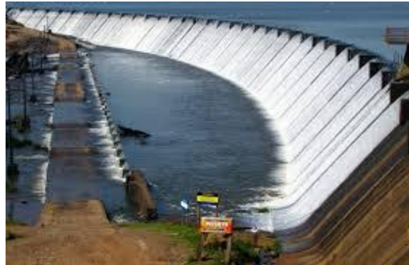
Barragem do Salto – Canelas/RS
